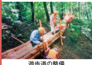
遊歩道の整備
